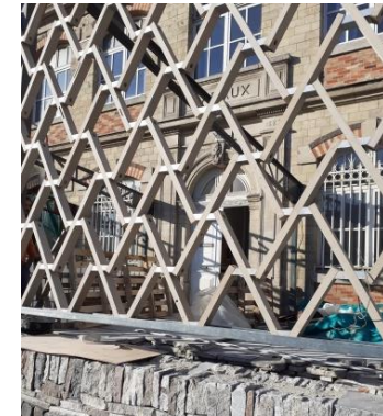
Platelage et treillage à partir de portes
