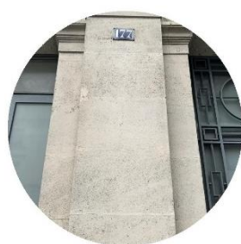
Pierre calcaire de colonne (5): 45 unités, 18 m 3 31 tonnes
