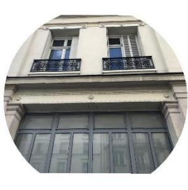
Linteaux : 16 unités 3 tonnes
