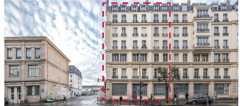
Immeuble à déconstruire, au 177 rue du Faubourg Saint-Denis, Gare Nord. Source : AREP
