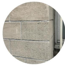
Pierre calcaire mur 39m 3 66 tonnes
