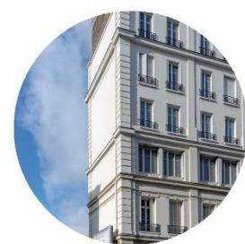
Pierre calcaire des colonnes supérieures 66 unités, 17 m 3 26 tonnes
