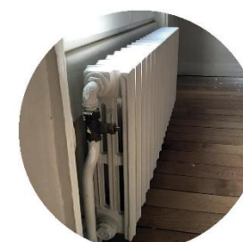
Radiateurs en fonte contemporains : 62 unités, 3,4 tonnes
