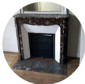
Cheminée : 23 unités dont dalles foyères 40m 2 de marbre soit 2,3 tonnes
