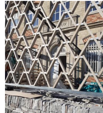
Platelage et treillage à partir de portes
